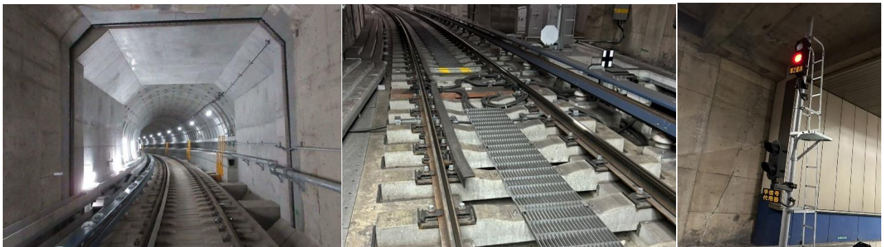
トンネル接続部
