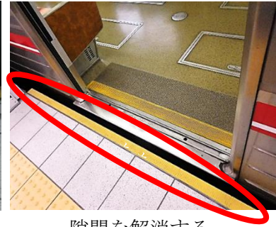
隙間を解消する 櫛状ゴムを設置
