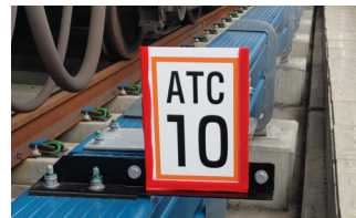
ATC 標識台への蛍光テープ貼付
