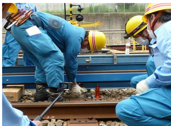
サードレール復旧訓練
