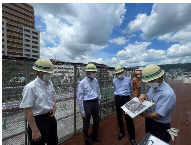
現場巡視(延伸工事)
