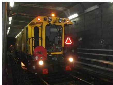
レール削正施工風景
