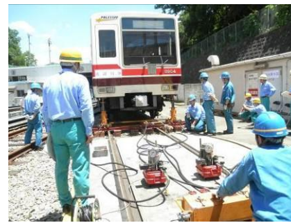
車両脱線復旧
