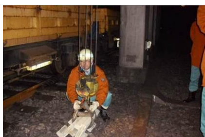
コンクリート片撤去 (クレーン使用)
