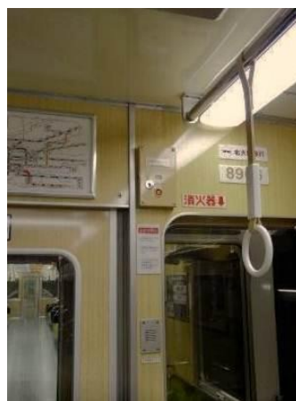
車内非常通報ボタン
