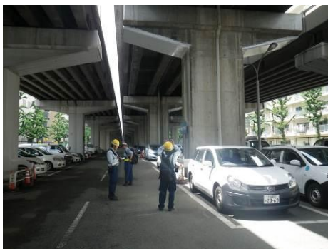
橋脚検査風景
