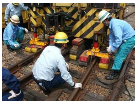
軌道モーターカー脱線復旧訓練
