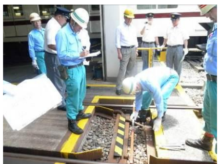
軌道四項目測定
