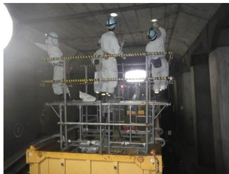
トンネル検査風景
